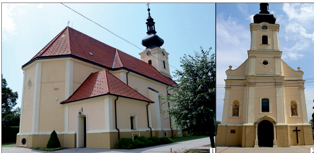
Obr. 1. Ludanice – farský Kostol Najsvätejšej Trojice: 1 – východný uzáver, sakristia a severná fasáda, 2 – západná fasáda (foto: M. Hanuš 2019).
