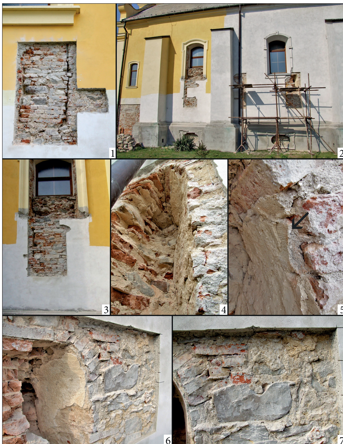
Obr. 17. Ludanice – farský kostol. Zamurované a čiastočne odkryté stredoveké okná severnej a južnej fasády lode: 1 – okno na severnej fasáde, 2 – celkový pohľad na južnú fasádu s trojicou stredovekých okien, 3 – západné okno južnej fasády, 4 – stredné okno južnej fasády, 5 – zvyšky maltových odtlačkov doskového debnenia v záklenku stredného okna južnej fasády, 6 – záklenok východného okna južnej fasády, 7 – štruktúra muriva v okolí záklenku východného okna južnej fasády (foto: M. Bóna 2007).
